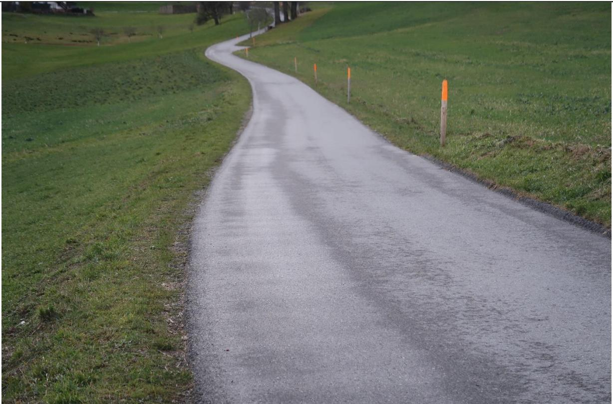
**Entwässerung über die Schulter**: Das Wasser fließt über die asphaltierte Strasse (ohne Schächte) in die nächste Parzelle) → **Keine Massnahme notwendig!**
