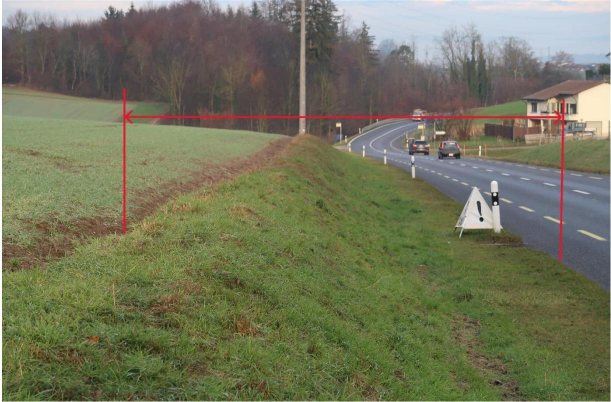
Bei einer Böschung wird die Breite des Grasstreifens horizontal gemessen.
