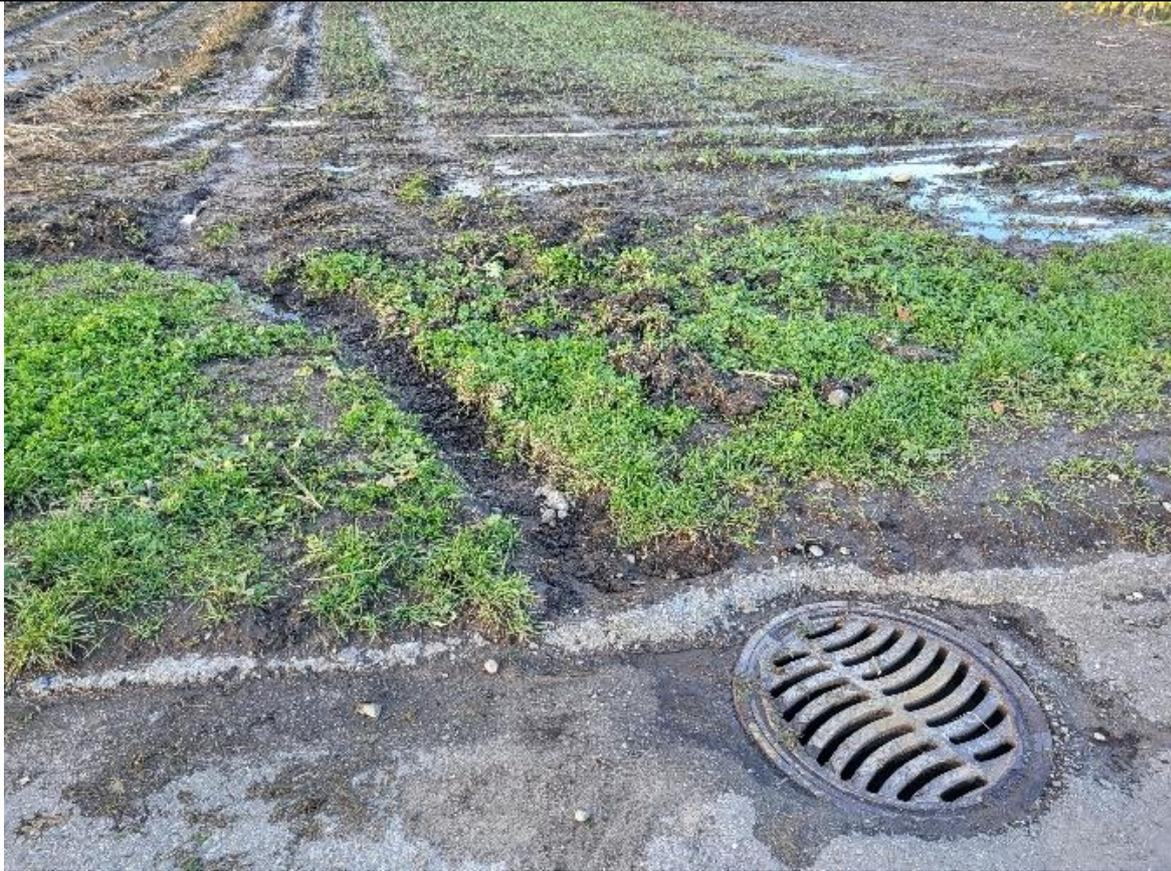
**Entwässerte Strasse:** Das Wasser läuft vom Feld auf Strasse/Weg, diese verfügt über ein Entwässerungsschacht der in ein Gewässer führt.
